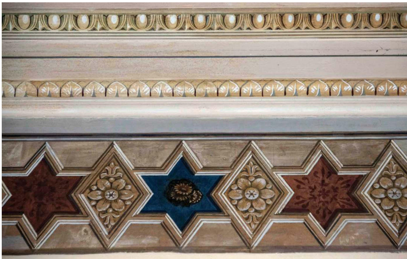
Habitación a la izquierda de la sala de la casa de Domingo Aldama
